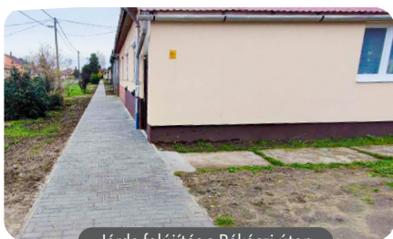
Járda felújítás a Rákóczi úton
